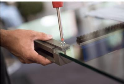
*Schritt 2/ Der Aufnahmekasten für das Band wird in das mit der Ausnehmung vorbereitete Glastürblatt montiert. Zwischen Türblatt und den metallischen Komponenten des Bandaufnahmekastens liegen die mitgelieferten Kunststoffplatten. Sie schützen das Glas und erhöhen die Klemmreibung. Foto: Patrick Hamacher, PH.OTOGRAPHIE, Würzburg*
