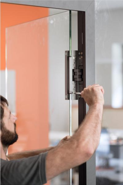
*Schritt 7/ Das Band wird mit dem Bandaufnahmekasten verschraubt. Anschließend wird das Türblatt mittels der dreidimensionalen Einstellmöglichkeiten im Band einjustiert. Foto: Patrick Hamacher, PH.OTOGRAPHIE, Würzburg*
