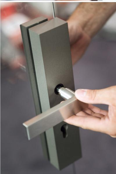
*Schritt 9/ Der Türgriff wird mit dem Schloss im Schlosskasten montiert. Foto: Patrick Hamacher, PH.OTOGRAPHIE, Würzburg*
