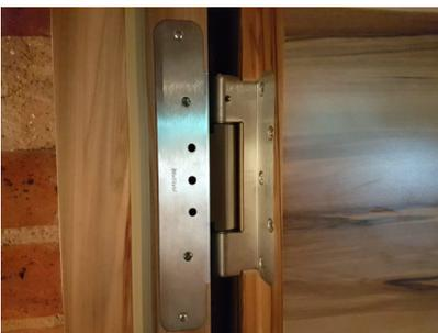
*Bildtext 5: Konzipiert für hohe Tragfähigkeiten: Das „Objecta 2539/160/48-4“ mit „STV 70/48 3-D“-Bandaufnahme sorgt dafür, dass die sehr breiten und schweren Türen im Hotel „Alte Ölmühle“ in Wittenberge reibungslos funktionieren. Gut sichtbar ist hier die Stiftsicherung, die allen „Objecta“-Türbändern eigen ist. Foto: Basys*
