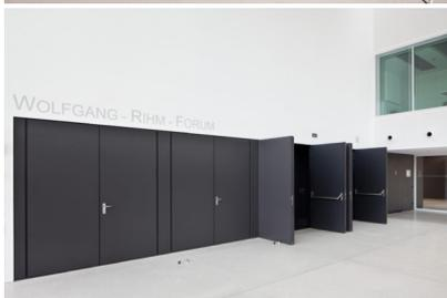
*Bildtext 2: Dass Türblätter und Wand flächenbündig verschmelzen, ist dem verdeckt liegenden Band „Pivota DX 180 3D“ von BaSys zu verdanken. Foto: Daniel Vieser Architekturfotografie, Karlsruhe, [www.dv-a.de](http://www.dv-a.de)*
