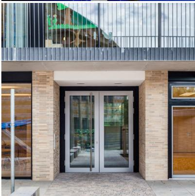
*Bildtext 7: In der Kindertagesstätte „Allerheiligen“ in Frankfurt kamen Objektbänder von Basys zum Einsatz. Die doppelflügelige Eingangstür, eine Holz-Alu-Konstruktion, besteht aus je vier Bandsystemen. Die Krebbers GmbH & Co. KG, Krefeld, verwendete die „Objecta“-Bänder „2541/160/56-4“ und die „Objecta“-Bandaufnahmen „STV 113/56 3-D“ für ein Türgewicht bis 160 kg (pro Paar). Foto: Daniel Vieser Architekturfotografie, Karlsruhe, [www.dv-a.de](http://www.dv-a.de)*
