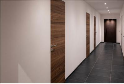
*Bildtext 1: Das flächenbündige Zargensystem „simi-lar“ von der Barthel GmbH, Tuntenhausen, kam mit flächenbündigen Sockelleisten in den Türen eines Luxus-Wohnhauses in München zum Einsatz – eine zeitgemäße Lösung für den gehobenen Innenausbau. Foto: Erol Gurian*
