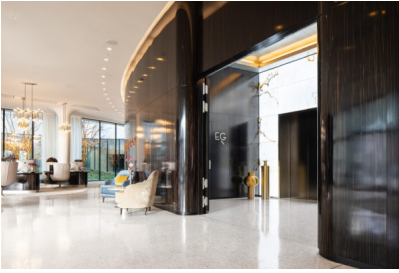
Bildtext 1: Eine Sonderlösung des Rollenbandsystems „Objecta“ im Einsatz in der Fahrstuhllobby des Grandhotels „The Fontenay“ in Hamburg. Die riesigen Türblätter mit Aufdopplung stehen 180 Grad geöffnet und schließen im Brandfall automatisch. Foto: Daniel Vieser Architekturfotografie, Karlsruhe, www.dv-a.de
