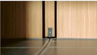
*Bildtext 5: Für die leichtgängige Mechanik und den schwellenlosen Übergang sorgt der oben laufende Schiebetürbeschlag „Hawa Media 70“. Die individuell gebogene Laufschiene montierte die Tischlerei im Türsturz. Sie wird von einer zweiteiligen Blockzarge umfasst, die über die Vorderseite revisionierbar ist. Foto: Hawa Sliding Solutions AG*
