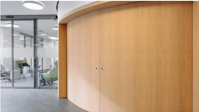
*Bildtext 4: Zwei 2.400 x 1.980 mm große Türflügel folgen dem Radius der Wand und verschwinden beim Öffnen vollständig in den Wandtaschen – ein Detail, das praktische Vorteile bietet: Die großzügige Durchgangsbreite von 3,50 Metern verbindet beide Räume fließend. Foto: Hawa Sliding Solutions AG*
