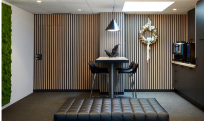
Bildtext 1: Wenn eine Tür ganz eins wird mit der Wand ... Spezielle Bandlösungen für Zargen- und Türblattaufdopplungen bereiten diesem Architekturansatz den Weg. Das Türblatt liegt dabei mit Zarge und Wand auf einer Ebene. Das Design der Wand lässt sich so über Türblatt und Zarge fortführen, dass sich Türen nur noch anhand einer minimalistischen Linienführung zu erkennen geben. Fotos: AGS systems
