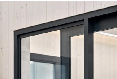
*Bildtext 3: Einheit von Optik und Funktion bei den Schiebetüren im Eingangsbereich: Die Holzrahmenkonstruktion mit einer Füllung aus Schallschutzglas fügt sich in das Design des Glastrennwandsystems und überführt das schwarze Fassadendesign in den Innenraum. Sie erreicht eine Schalldämmung von Raum zu Raum von circa Rw 39 dB. Die Technik bleibt verborgen. Foto: Oliver Jaist Fotografie, Vahrn*
