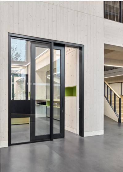
*Bildtext 2: Die zwei Schiebetüren zu den Büros im Erdgeschoss ermöglichen es, sich von den Geräuschen im Atrium abzuschirmen und im Winter vor Zugluft, die über die Schiebetüren im Eingang hereinweht, zu schützen. Foto: Oliver Jaist Fotografie, Vahrn*
