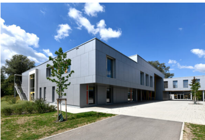
Bildtext 1: Der 2020 fertiggestellte Erweiterungsbau der Gerhard-Thielcke-Realschule in Radolfzell. Die vorgehängte hinterlüftete Fassade mit „Trespa Meteon“ trägt das Dekor „Tempered Grey NM06“ in Matt aus der „Naturals“-Kollektion. Wassertropfen scheinen auf einem Stein zu gefrieren und rufen im Licht lebendige Reflexionen hervor. Foto: Susanne Sommerfeld, Konstanz
