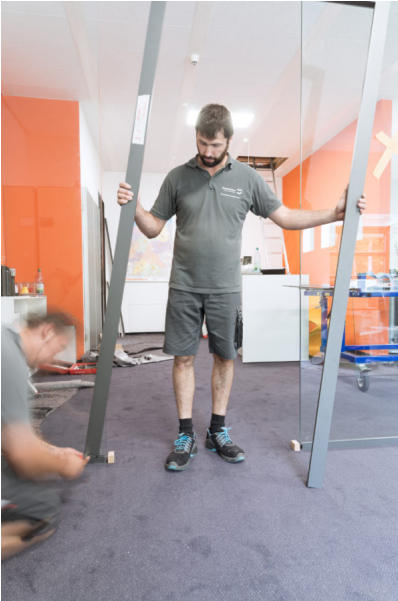
Schritt 4/ Die Zarge wird gesetzt, hier eine Aluminiumzarge, und fachmännisch ausgerichtet. Foto: Patrick Hamacher, PH.OTOGRAPHIE, Würzburg
