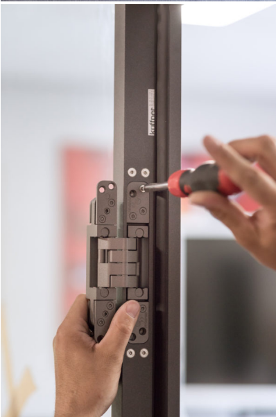
Schritt 5/ Die verdeckt liegenden Bänder werden in die Zarge gesetzt und verschraubt. Foto: Patrick Hamacher, PH.OTOGRAPHIE, Würzburg
