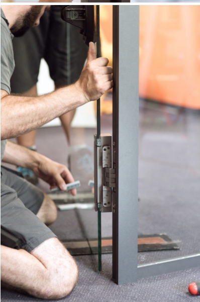
Schritt 6/ Das vorbereitete Türblatt wird eingehängt. Foto: Patrick Hamacher, PH.OTOGRAPHIE, Würzburg
