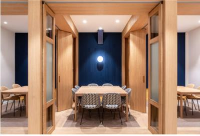
*Bildtext 3: Funktional, ästhetisch und flexibel – zwei fünfteilige Holz-Trennwände öffnen den Raum zu einer großen Einheit oder gliedern ihn in zwei respektive drei kleinere Einheiten. Dabei kommt der „Hawa Centerfold“ zum Einsatz, ein Schiebebeschlag für Harmonikawände. Die mittige Aufhängung der Elemente trennt die Einheiten gleichmäßig und sorgt dafür, dass der Parkraum diskret auf der Seite platziert werden kann. Foto: Hawa Sliding Solutions AG*
