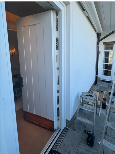
Bildtext 4a + b: Beispiele für Haus- bzw. Wohnungseingangstüren wie sie bei Masei Standard sind: Drei „Pivota DX 200“-Bänder und vier Bandseitensicherungen erreichen Einbruchschutzklasse RC IV. Die zwei Kabelübergänge „Pivota Connect“ versorgen einerseits das Motorschloss mit Strom, andererseits die Sicherheitseinrichtungen, wie Kamera, Durchbruchmelder und Alarmmatte. Alle Beschlagprodukte stammen von Basys; ihre Oberflächen wurden aufeinander abgestimmt. Fotos: Masei
