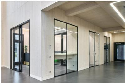
*Légende 4+5 : Des éléments de porte à la fois transparents et hermétiques, qui s'ouvrent et se ferment de manière flexible sans gêner ou encombrer davantage l'espace, ont été créés dans le nouvel immeuble de bureaux, conformément aux directives des architectes et aux souhaits du maître d'ouvrage. Photos : Oliver Jaist Fotografie, Vahrn*
