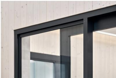
*Légende 3 : Unité esthétique et fonctionnelle des portes coulissantes de la zone d'entrée : La structure à ossature bois avec un panneau en verre insonorisant s'intègre dans la conception du système de parois de séparation en verre et transpose le design noir de la façade dans l'espace intérieur. Elle offre une isolation acoustique d'une pièce à l'autre d'environ Rw 39 dB. La technique est dissimulée. Photos : Oliver Jaist Fotografie, Vahrn*
